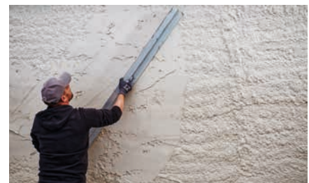
Abrichten der Putzoberfläche
