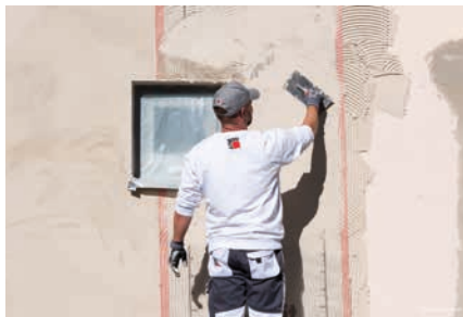
Als Armierungsputz zur sicheren Rissüberbrückung
