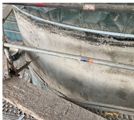
LTM 81 schafft Mauerwerksausgleich mit geeigneten Putzträgermaterialien und flächigen Dickenaufbau in hoher Schichtstärke bis 20 cm
