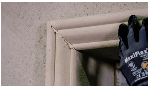
Verklebung Stuckprofil mit multiContact MC 55 W.
