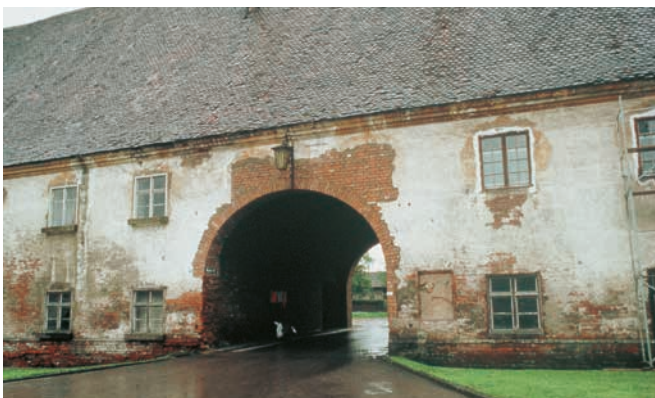
Viele historische Gebäude leiden unter feuchtem, salzhaltigem Mauerwerk.
