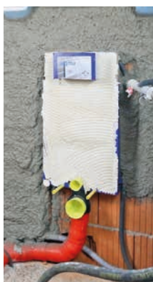
Maschinelle, effiziente Schlitzverfüllung in einem Arbeitsgang auch bei hohen Auftragsdicken möglich. Auch perfekt für die Handverarbeitung.
