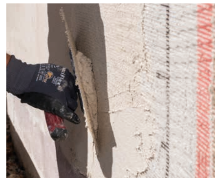
Antragen und Durchkämmen des multiContact MC 55 W. Armierungsgewebe lassen sich perfekt einbetten.
