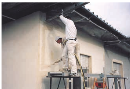
Risse, die sich stärker bewegen, lassen sich nicht immer sicher allein mit einer Armierungsputzlage überarbeiten. In diesen Fällen hilft eine zusätzliche Schicht Baumit Nadel filzVlies, das unter dem Gewebe eingespachtelt wird, um die Bewegungsenergie aufzunehmen. Damit wird das Auftreten weiterer Risse an der Fassade deutlich minimiert.
