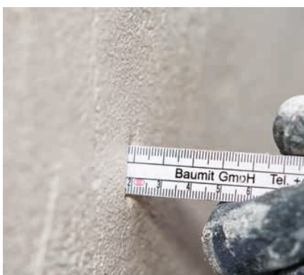
Prüfen der gewünschten Schichtdicke
