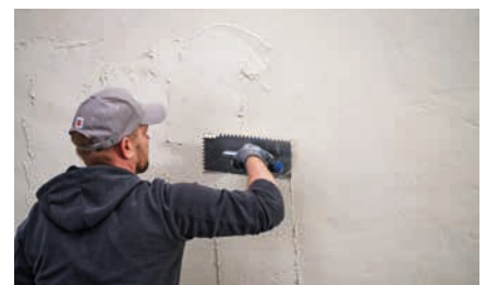
Dünnschichtputz auf Porenbeton
