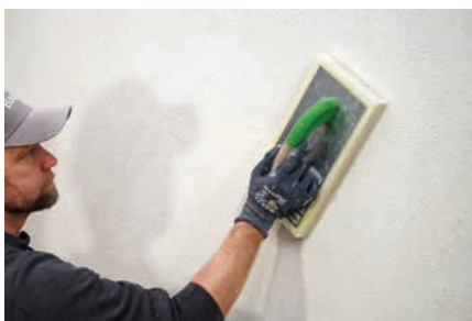
Zur Ausführung eines perfekt auszufüllenden Oberputz
