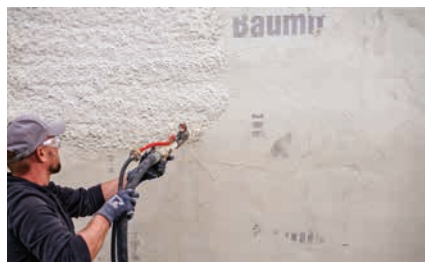
Nach Einbetten des Gewebes, nass in nass erneuter Materialauftrag (Gewebe darf nicht oberflächensichtig sein)
