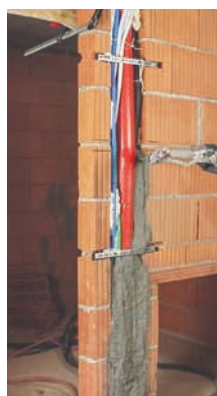
Maschinelle, effiziente Schlitzverfüllung in einem Arbeitsgang auch bei hohen Auftragsdicken möglich. Auch perfekt für die Handverarbeitung.
