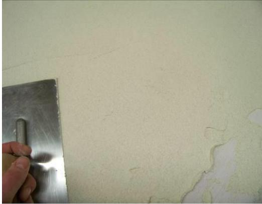
Die Putzschicht zum Strukturieren der Oberfläche leicht matt antrocknen lassen. Anschließend die Oberfläche leicht mit einer Wasser-Sprühflasche anfeuchten. Die Putzschicht glatt Abtraufeln (Überfahren), bis sich kleine Poren und Nester im Putz bilden.
