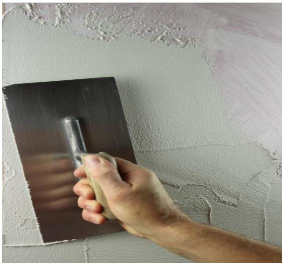
Lässt sich der Putz auf Grund von zu hoher Feuchtigkeit nicht abtraufeln, so muss noch einmal eine Trockenzeit abgewartet werden, bis er leicht matt abtrocknet.
