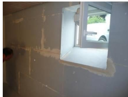
Wandöffnungen mit Pistolenschnitt herstellen. Platten im Versatz verlegen.
