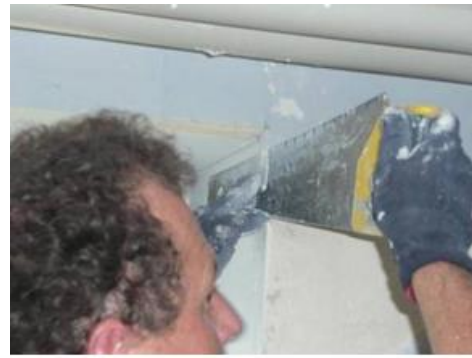
Plattenüberstände in Laibungen können einfach vor Ort mit dem Fuchsschwanz abgesägt werden.
