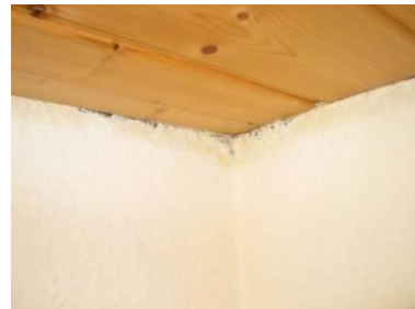
Wärmebrücke – Decke zum ungedämmten Dachgeschoss
