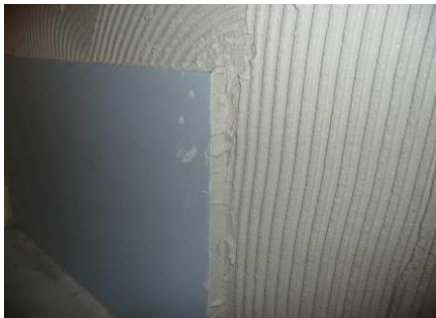
Die Stoßkante der schon aufgeklebten Platten sind satt mit AS 2 in 1 Putz zu versehen.
