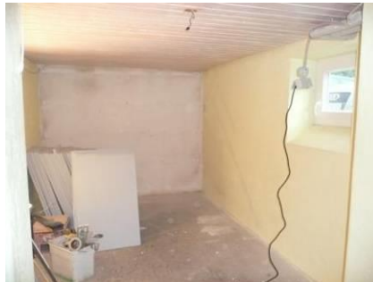
Schimmelbehandlung mit AS Fluid im Kellerraum
