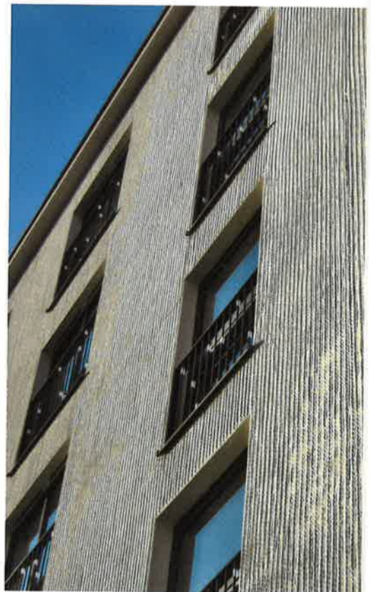
Bei dem Münchner Gebäude „Haus Nonnenmacher“ zeigt sich die WDVSystem-Fassade unter einem mit Schnüren strukturierten Putz.
