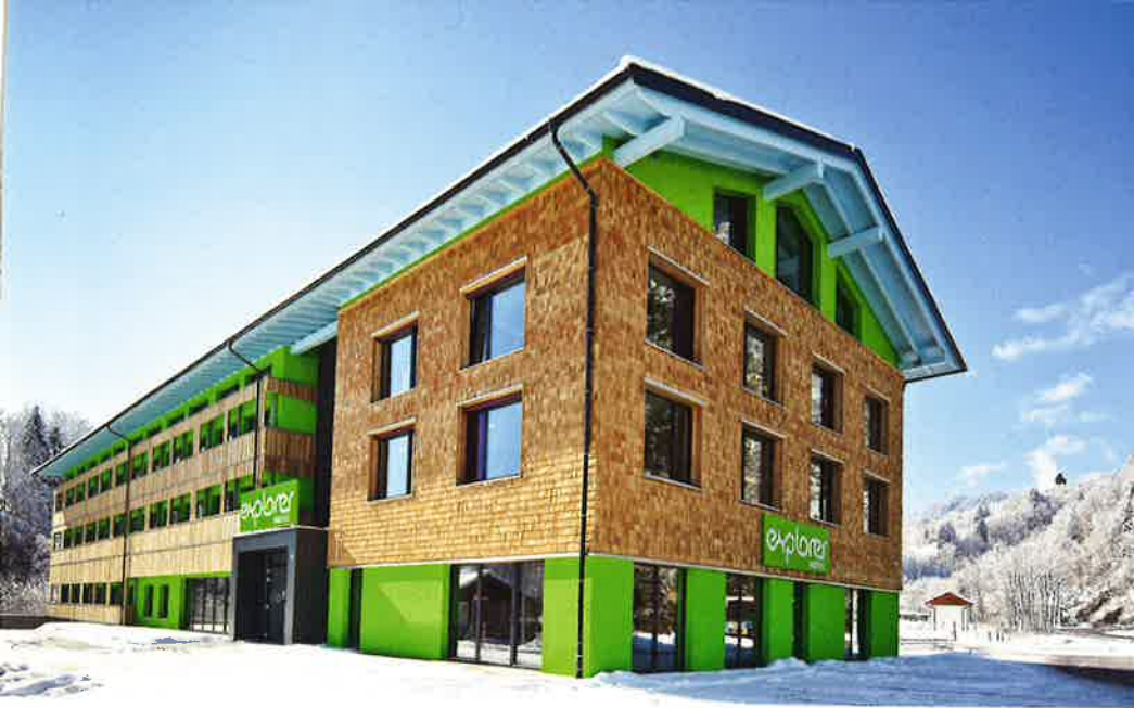
Das Sporthotel in Oberstdorf zeigt eine moderne Mischung aus fachgerecht gedämmter Holz- und Putzfassade.
