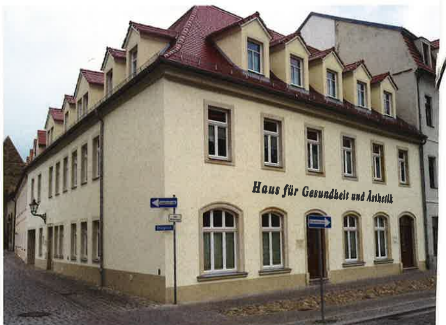
Sanierte historische Fassade in Großenhain: Im Haus für Gesundheit und Ästhetik befinden sich ärztliche Einrichtungen und ein medizinisches Institut.
