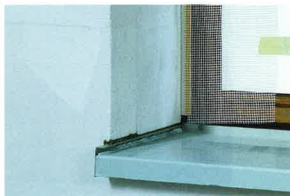
Detail einer Anschlussabdichtung
