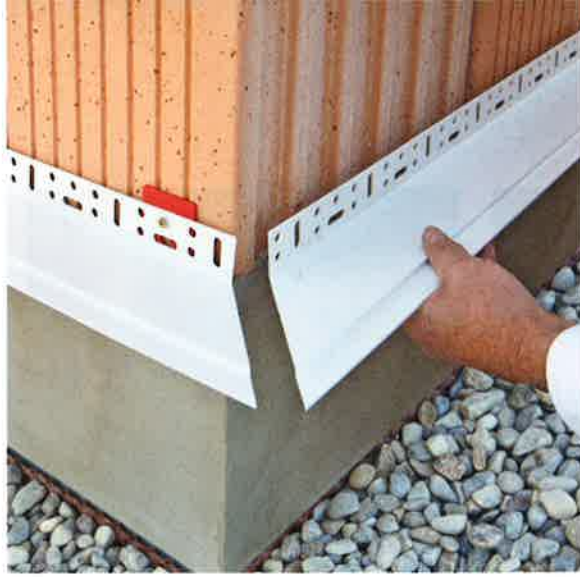
Sockelschiene Eckausbildung
