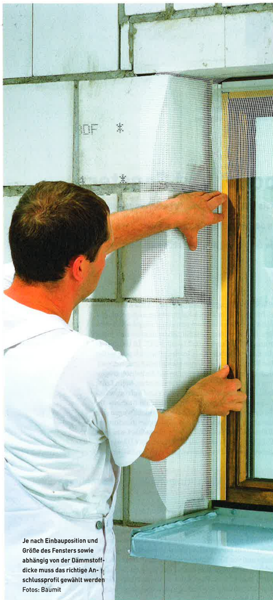
Detail einer Anschlussabdichtung
