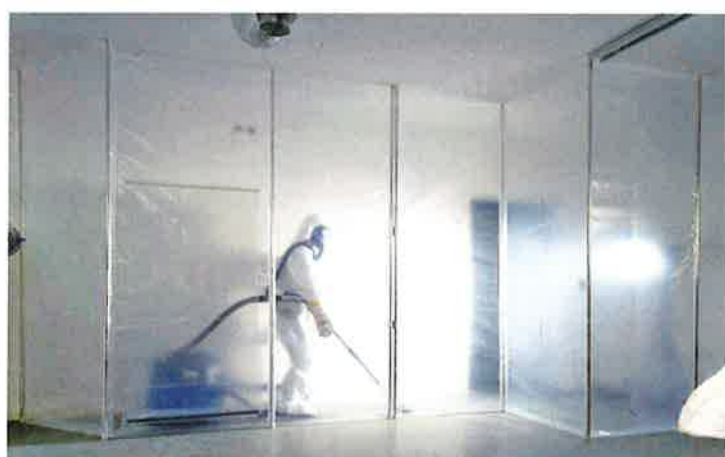
5 + 6 Abhängig von der Gefährdungsklasse sind Schutzmaßnahmen vorzusehen, zum Beispiel ein staubdichter Schutzanzug. Fotos: Baumit
