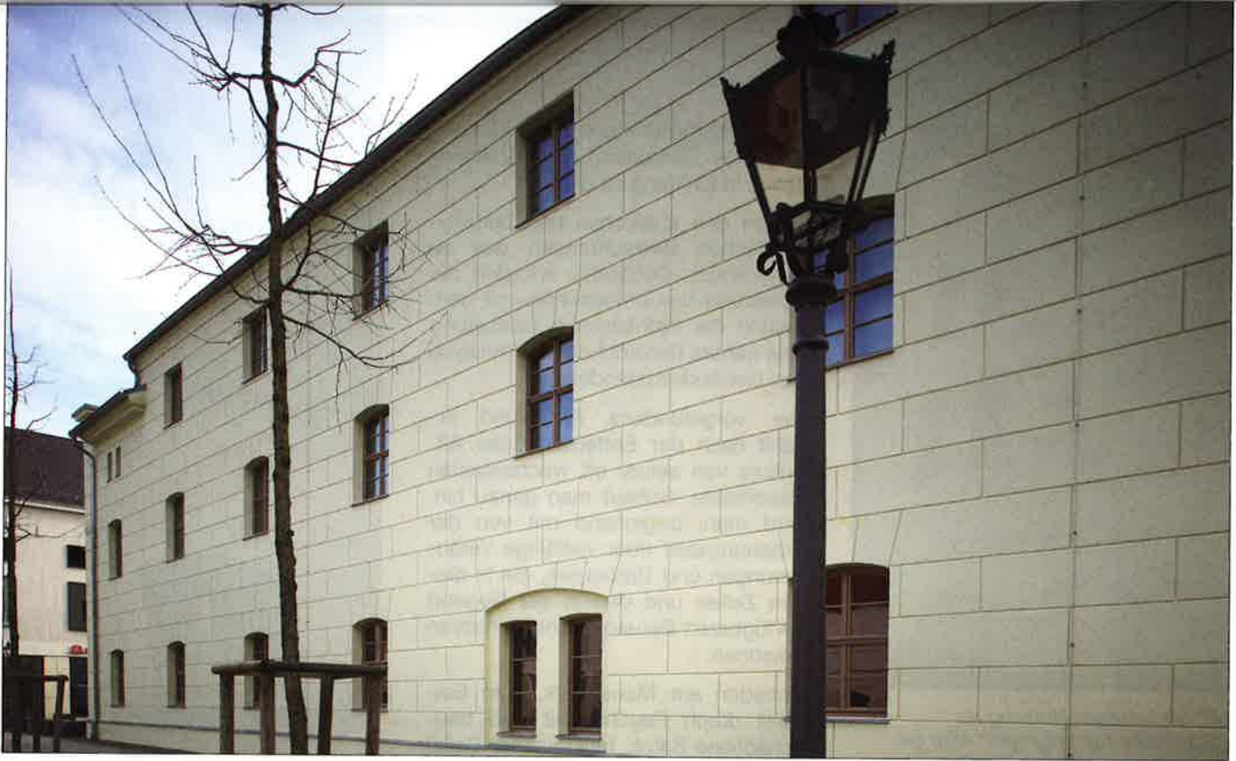
Die Farbgebung erfolgte mit einer silikatisch gebundenen Farbe.
