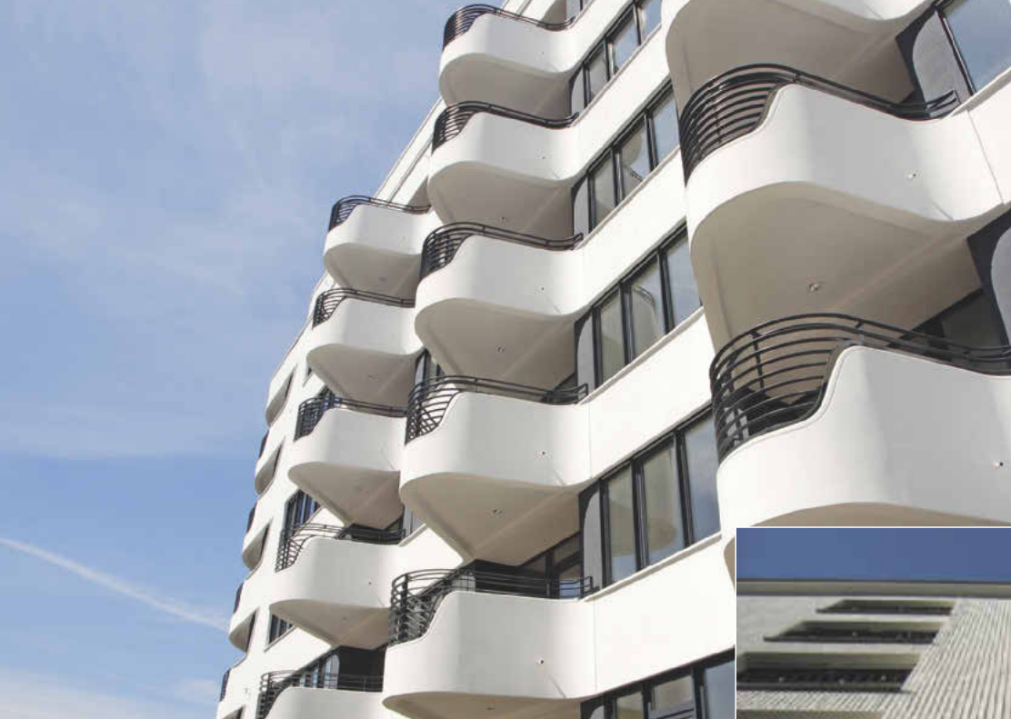
Berlin, The-White-Strahlauer Allee: Die individuelle Gebäudeform kommt durch einen weißen Anstrich besonders gut zur Geltung.
