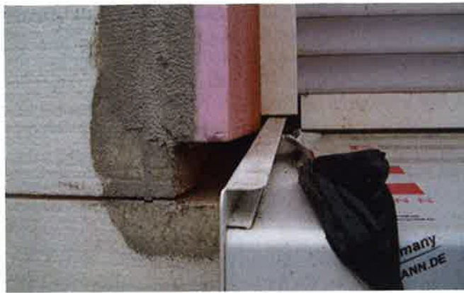
4 Ein kritisches Detail ist die sogenannte Gewerke­lücke am Übergang von Fensterbank, Rollladenführungsschiene und Fenster. Bei diesem Beispiel mangelte es an einer sorgfältigen Planung und es würden ungeeignete Fensterbank-Abschlussprofile verwendet.
