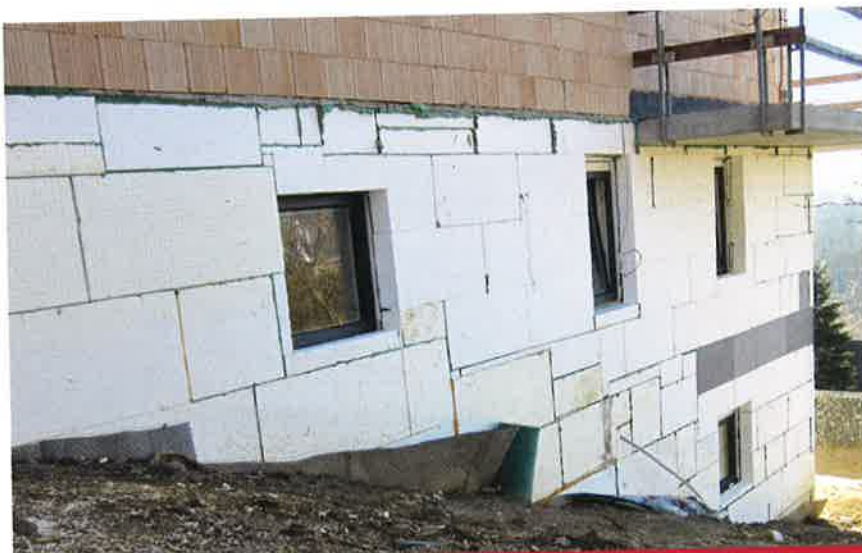
Perimeterdämmplatten im Sockelbereich.
