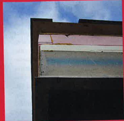
Untergrund aus Baustoffmix.
