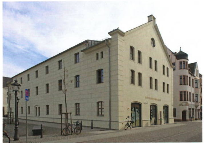
Nach der Sanierung mit „multiFine RK 70 N“ zeigt sich das Gebäude mit einer feinen hellen Fassadenstruktur
