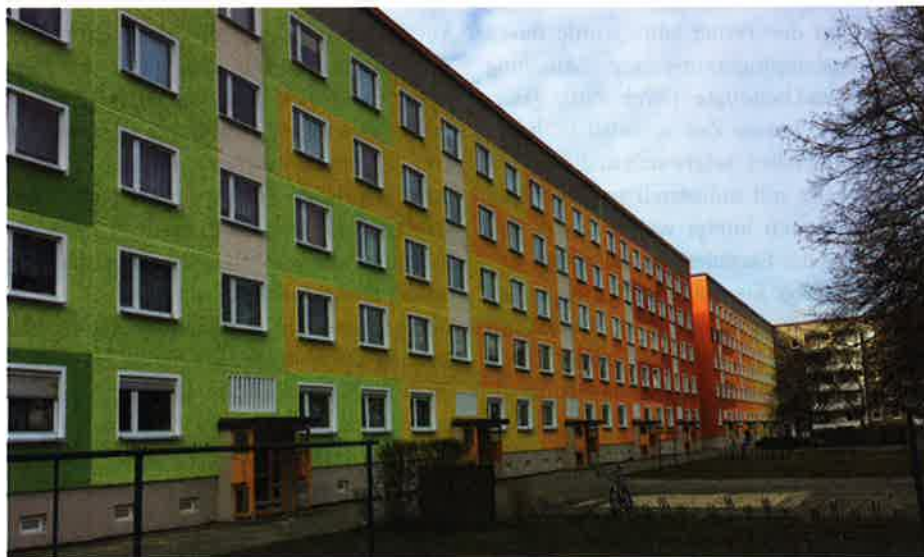
Bild 8: Die Farbgebung verkürzt den langen Gebäuderiegel optisch und schafft ein farbenfrohes Wohnumfeld bei gleichzeitiger Verbesserung des Witterungsschutzes
