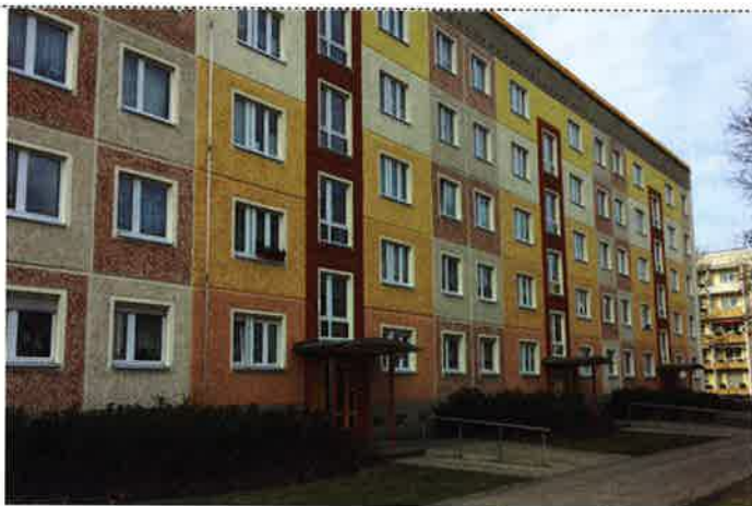
Bild 4: Am Plattenraster der Fertigteile orientierte Farbgebung an einem kleineren Wohnblock
