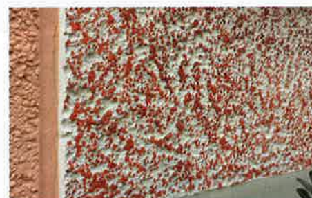
Bild 5: Der zweifarbige Farbauftrag erzeugt auf der bekliesten Platte eine Siebdruckoptik
