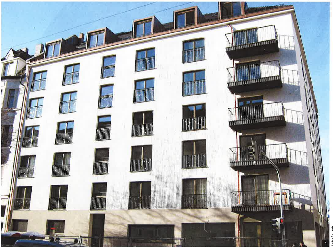
Abb. 1: Besonders mit pastösen Putzen lassen sich individuelle Strukturen schaffen. Bei diesem Gebäude in München wurde eine Seilkordel als individuelles und strukturgebendes Hilfsmittel eingesetzt.
