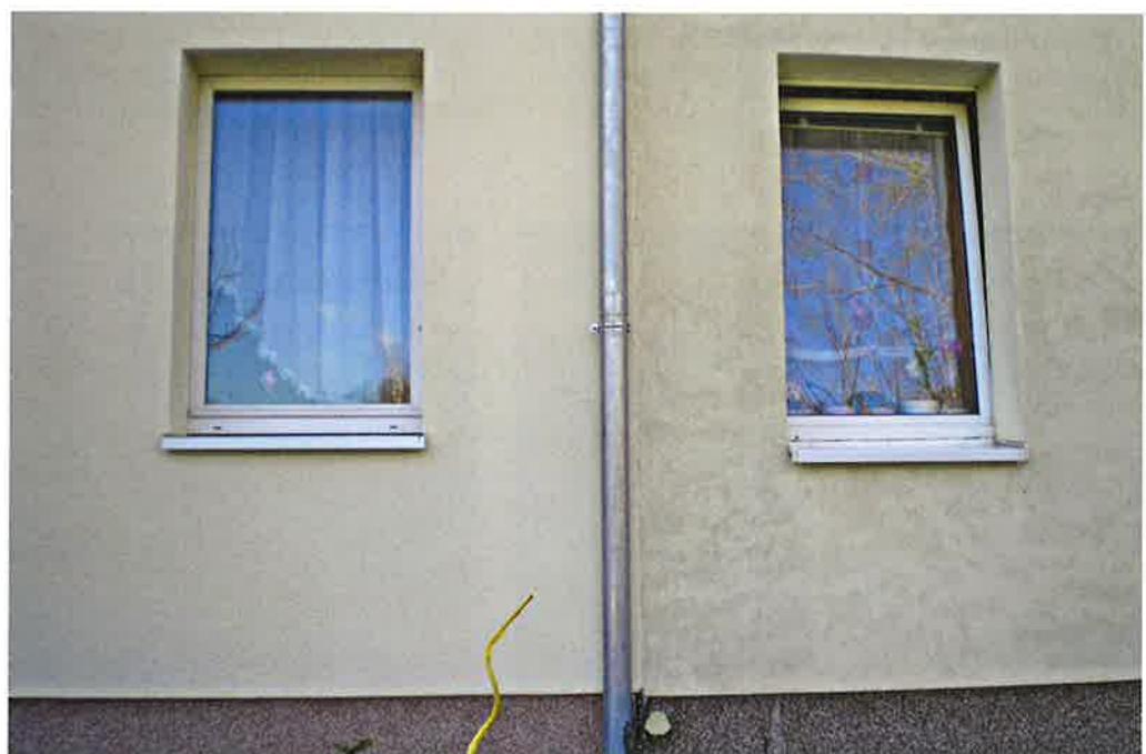
8 Vergleich nach zwei Jahren: Nanopor links, der normale Putz rechts. Fotos/Grafiken: Baumit
