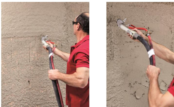
Ausgleich des Saugverhaltens durch zweischichtigen Putzauftrag nass in nass
