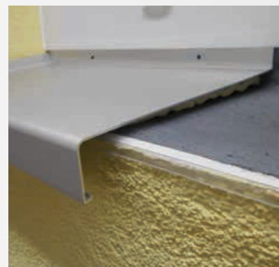
Fensterbank mit zweiter Dichtebene
