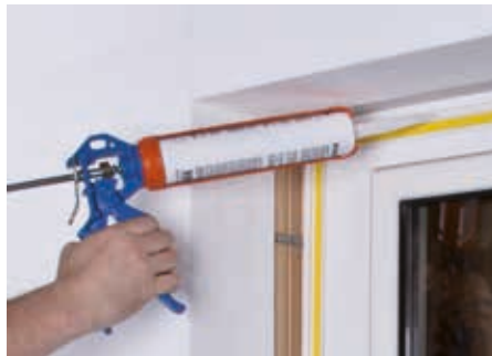
Auftragen des Baumit MontageKlebers im Anschlussprofil.
