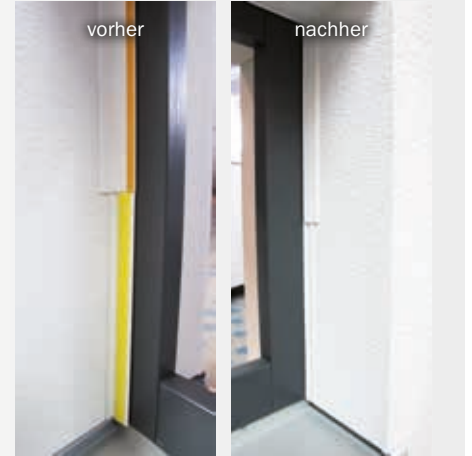
Das Anschlussprofil U-AL (oben) und das Anschlussprofil U-DA (unten) sind überstreichbar.
