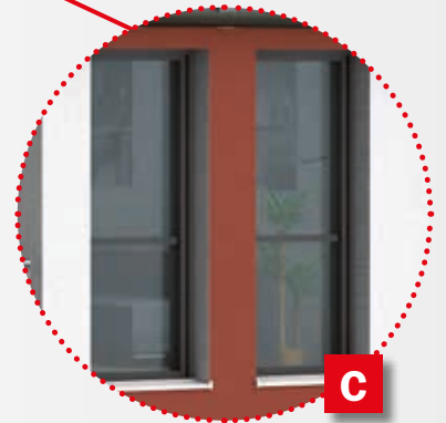
Fenster mit Rollladenführungsschiene
