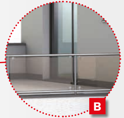
Sockel fassadenbündig mit Blechanschluss
