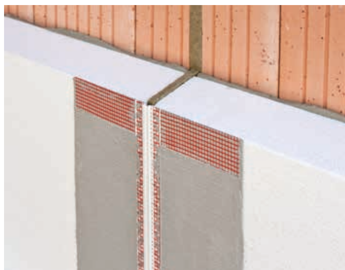
Hohlräume hinter den Profilen müssen immer mit Mineralwolle ausgefüllt werden.
