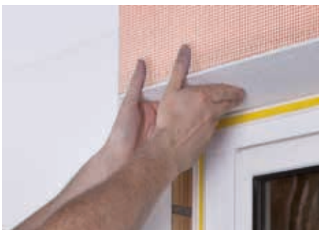
Laibungselement einschieben. Zuerst das Sturzelement, anschließend die Seitenelemente einschieben.
