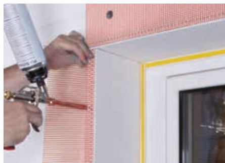
Das Laibungselement leicht wegklappen und mit Baumit easy pro KlebeSchaum hinterschäumen.
