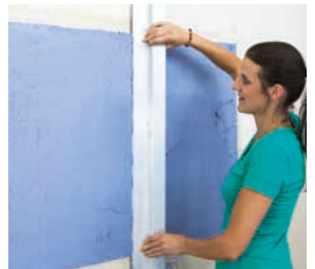
Gerade Abzugskante in verschiedenen Höhen für unterschiedliche Putzoberflächen.
