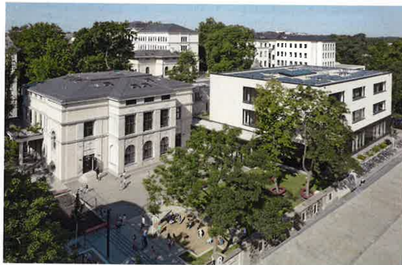
Einheitliches Ensemble: (links) Hort im ehemaligen denkmalgeschützten Gemeindehaus und (rechts) Schulneubau.
