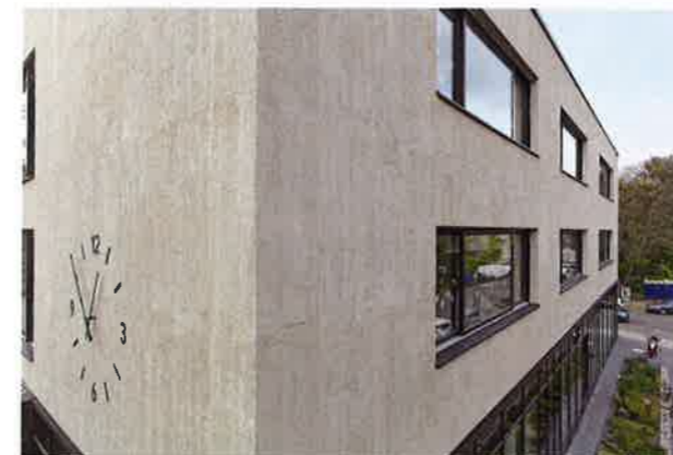
Schulneubau mit Putzfassade in kreativer Besen-technik: Mit grober Drahtbürste oder Putzkamm wird in den noch feuchten Putzflächen eine vertikale Bürstenstruktur erzeugt.
