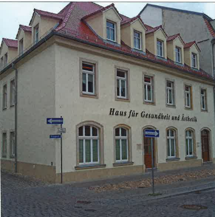
Haus für Gesundheit und Ästhetik in Großenhain. Zum Einsatz kamen Wärmedämm-Verbundsystem openTherm 032 G, ScheibenPutz SEP.
