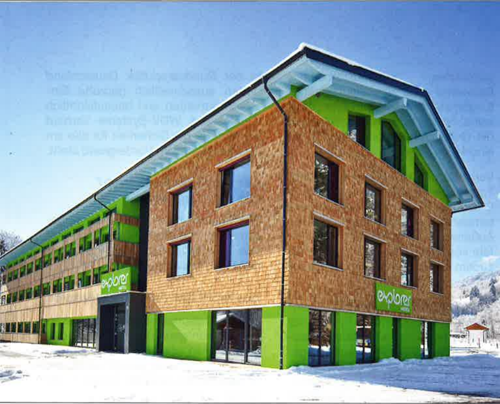
Explorer-Hotel in Oberstdorf: Wärmedämm-Verbundsystem EPS, GranoporTop intensiv
