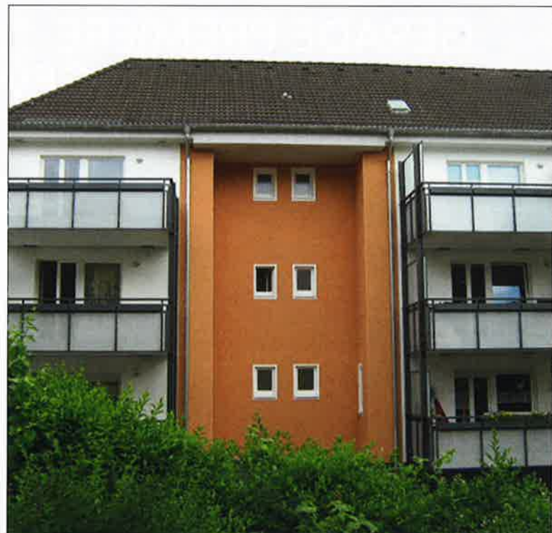
Objekt in Düsseldorf (Torfbuchstraße): Wärmedämm-Verbundsystem EPS 035 mit dickschichtigem Kratzputz.
