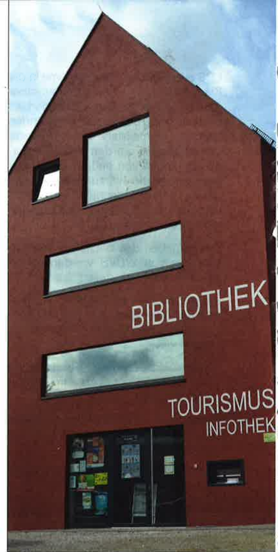
Bibliothek in Vohburg mit Wärmedämm-Verbundsystem EPS 035 und GranoporTop Kratzputz (Fotos: Baumit)
