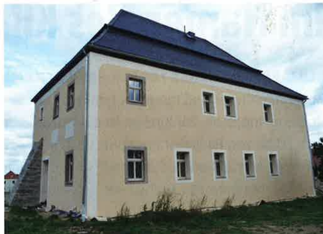
5, 6 Bei diesem historischen Herrenhaus in Obergurig war das Mauerwerk erheblich von auskristallisierenden Salzen geschädigt. Nach der Sanierung mit einem Sanierputz erstrahlte das Anwesen in neuem alten Glanz, und es wird diese Optik sehr wahrscheinlich für lange Zeit ohne erneute Putzsanierung beibehalten.
