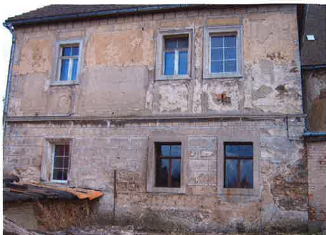
5, 6 Bei diesem historischen Herrenhaus in Obergurig war das Mauerwerk erheblich von auskristallisierenden Salzen geschädigt. Nach der Sanierung mit einem Sanierputz erstrahlte das Anwesen in neuem alten Glanz, und es wird diese Optik sehr wahrscheinlich für lange Zeit ohne erneute Putzsanierung beibehalten.
