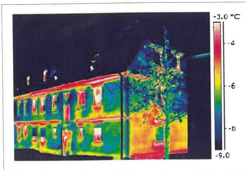
Ungedämmtes Gebäude: Die Infrarotaufnahme zeigt Wärmebrücken. Die roten Bereiche sind Wärmelecks, bei denen Energie entweicht
