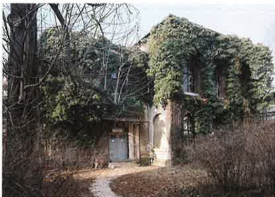
forum thomanum: das denkmalgeschützte Hortgebäude vor der Sanierung
