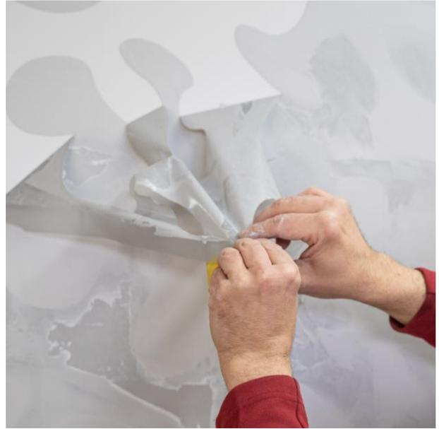
5. Abstehende Grate werden nach Trocknung des Putzes entfernt.
