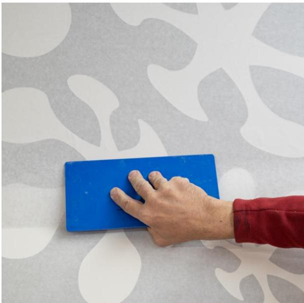
2. Nach und während dem vorsichtigen Entfernen der Trägerfolie wird die Schablone nochmals mit einem fusselfreien Tuch auf den Untergrund angedrückt, um ein Hinterlaufen zu vermeiden.
