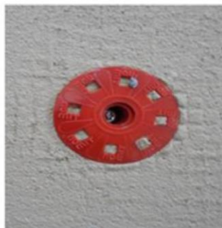
in das in die Armierung gebohrte Loch wird der Dübel oberflächenbündig eingesteckt
