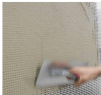
und mit Armierungsmörtel abdecken
