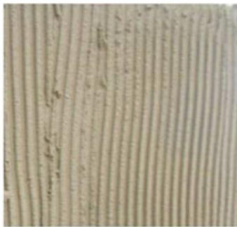
Armierungsmörtel mit Zahntraufel gleichmäßig auftragen
