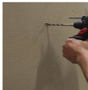
8 mm Loch für Dübel durch die frische Armierungsschicht bohren
