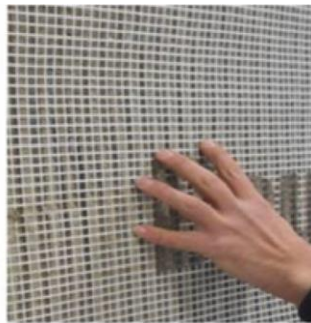
Armierungsgewebe StarTex Grob einlegen
