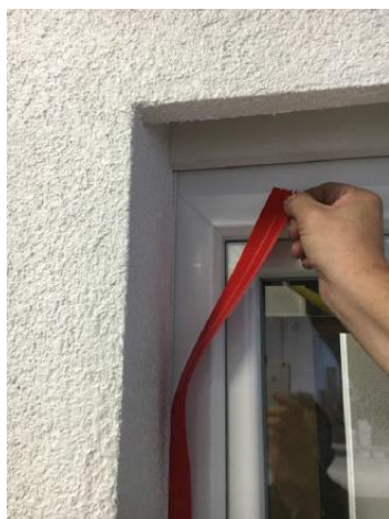
Herausziehen des Klemmprofils zur Aktivierung
