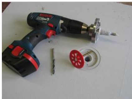
Um eine ebene Fläche zu erreichen, sind die Tellerdübel versenkt anzubringen.
