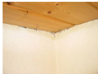
Wärmebrücke – Decke zum ungedämmten Dachgeschoss
