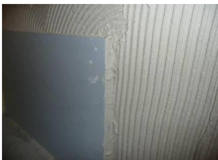
Die Stoßkante der schon aufgeklebten Platten sind satt mit AS 2 in 1 Putz zu versehen.
