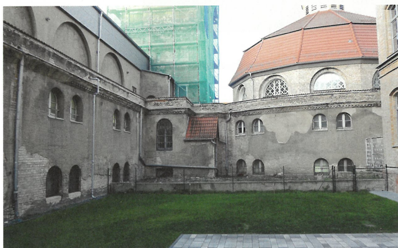
Halle Stadtbad: Vorherrsituation
