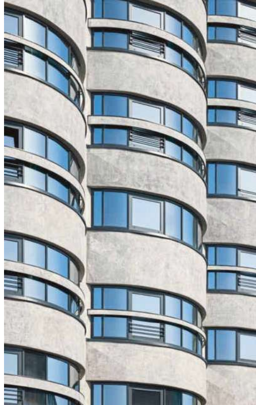
Die Dämmung der gerundeten Silowände stellte eine besondere handwerkliche Herausforderung dar.
