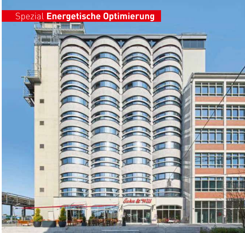
Einst lagerten tausende Tonnen Getreide in den Silos auf der Bremer Überseeinsel. Heute befinden sich in den Betonröhren außergewöhnliche Hotelzimmer.
