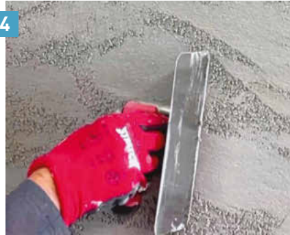
4 Sobald der Putz oberflächlich matt aufgetrocknet, wird mit einer venezianischen Glättkelle unter gleichmäßigem Druck die Oberfläche aufgeraut.
