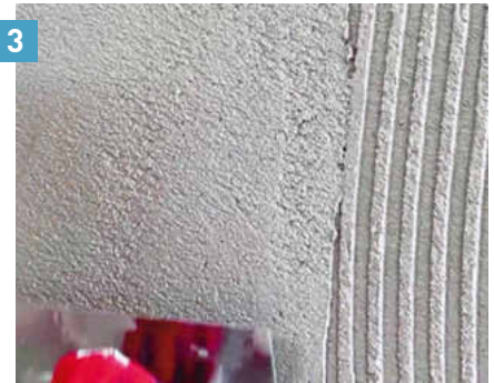
3 ... und anschließend mit einem Flächenspachtel abgeglättet. Die Schichtdicke muss mindestens acht Millimeter betragen.
