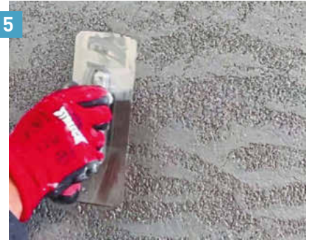
5 Im Anschluss kann die Oberfläche mit der venezianischen Glättkelle nochmals nachgeglättet werden, was zu einer etwas feineren Optik führt.
