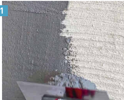
1 Der werkseitig eingefärbte Kratzputz wird auf den vollständig durchgetrockneten Haftputz in einer gleichmäßigen Schichtdicke aufgetragen.
