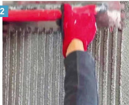
2 Für eine gleichmäßige Schichtdicke wird der Kratzputz mit einer Zahnkelle oder Zahnkartätsche (Zahnung 10 oder 12 mm) abgezogen...
