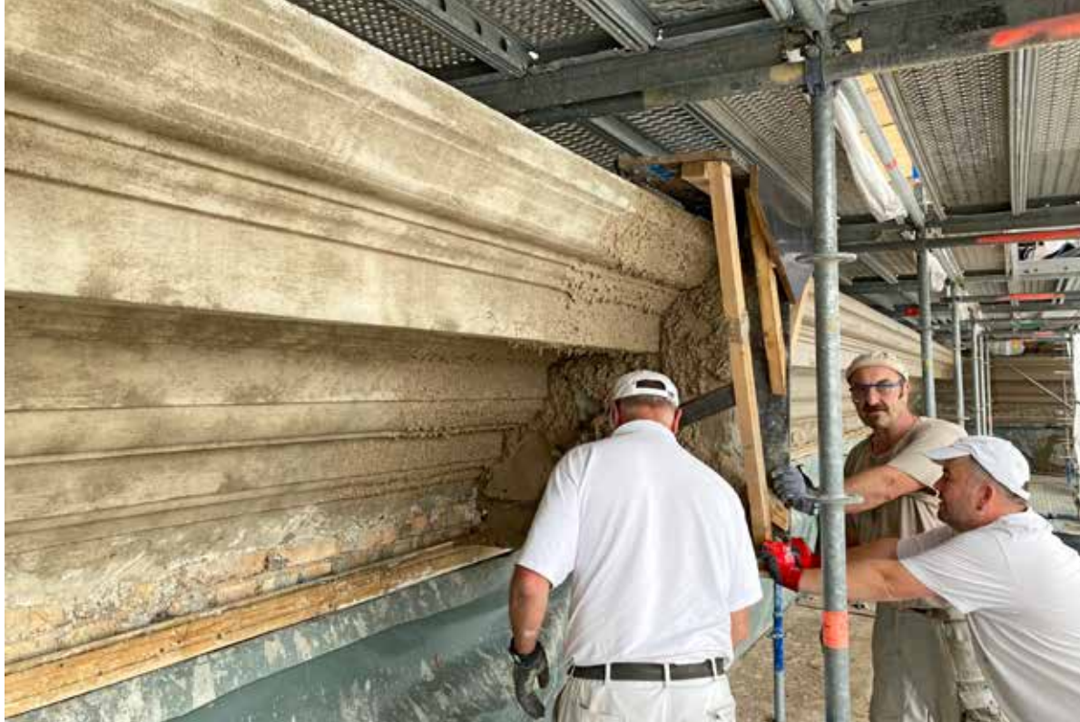
Der Grobzug des Gesimses erfolgte mit der Zugschablone auf einem Lattengang
