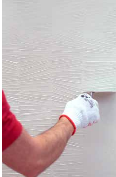
Uchiwa: Hier entsteht die Struktur mit der Kante einer Kelle. Eine gleichmäßige Schichtstärke ist entscheidend
