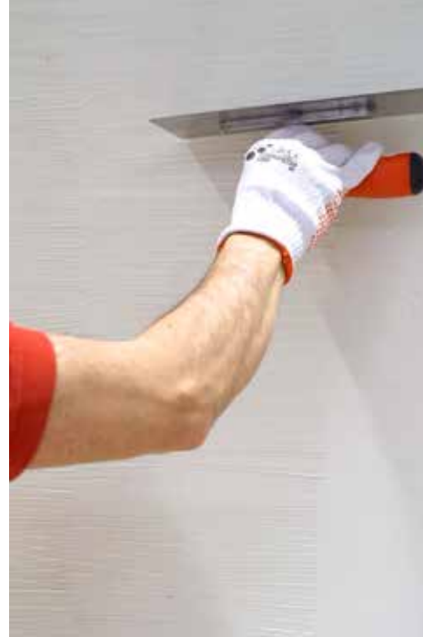
Weidengeflecht: Die Technik wird durch übereinander gehende, verflochtene Züge mit dem Rücken der Glätte ausgeführt
