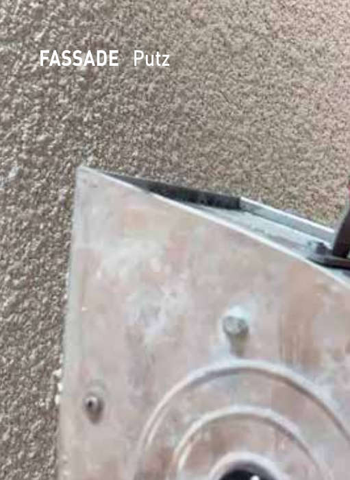
Leierputz: Der dünnflüssig eingestellte Edelputz wird mit der Putzleier aufgespritzt. Er wirkt lebendig und leicht reliefiert
