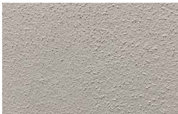
Gefilzt: Die Optik wirkt ruhig und wird mit einem Schwammbrett realisiert
