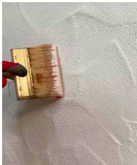
Mit Bürste und Kellen wird die Fläche gleichmäßig modelliert
