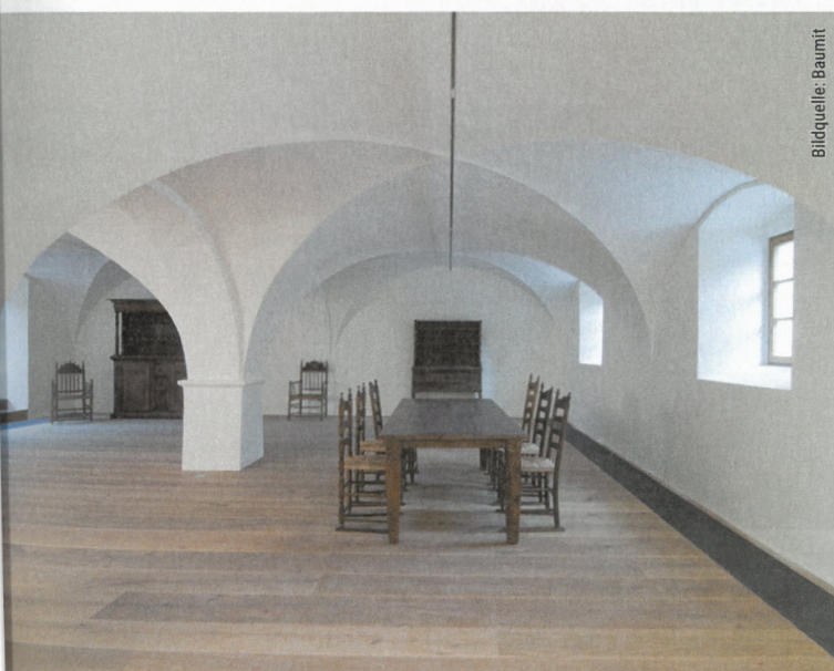
Abb. 3: Das wunderschöne Kreuzgewölbe in den Erdgeschossräumlichkeiten konnte mit Kalkputz verputzt werden.
