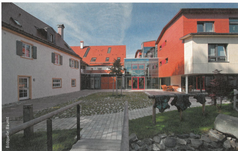
Abb. 8: Der gesamte hintere Teil des Ensembles musste einem Neubau weichen. Hier wurde ein Seniorenwohnprojekt realisiert.
