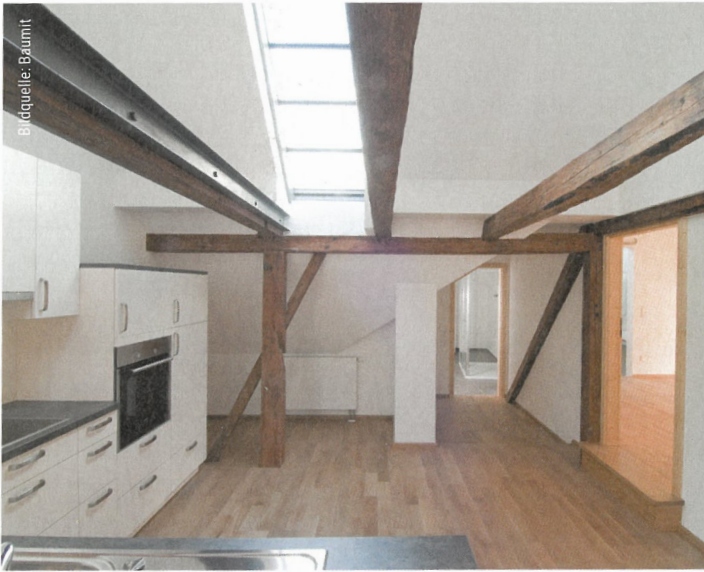
Abb. 5: Für die Küche kam ein zementfreier Kalkputz zur Ausführung, welcher teilweise beflieset wurde.
