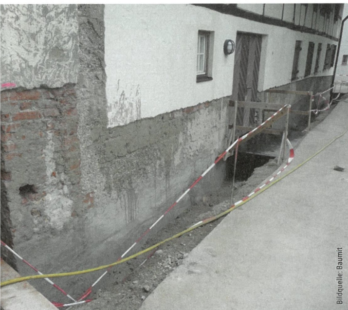
Abb. 1: Für die Abdichtungsarbeiten ein Idealfall. Nachdem das Mauerwerk sehr gleichmäßig gemauert ist und die Fugen nicht zu tief sind, werden keine besonderen Ausgleichslagen benötigt. Allein mit einer mehrmals aufgetragenen Dichtungsschlämme konnte die Abdichtung erstellt werden.
