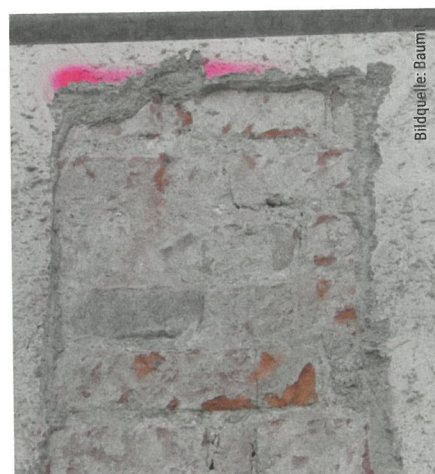
Abb. 4: Hier wird es schwierig, die erforderlichen Putzdicken einzuhalten. Am unauffälligsten ist es, wenn man den Sanierputz in der erforderlichen Dicke nach oben hin langsam auf das bestehende Niveau auslaufen lässt. Eine Erhöhung der Sanierputzgrenze und eine sorgfältigere Nachbehandlung sind zusätzlich einzuplanen.
