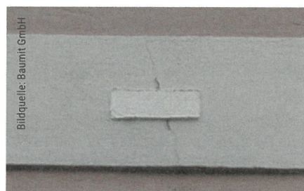
Abb. 8: Aufgebrachte Rissmarken („Rissplomben“) zur Kontrolle und Dokumentation der Rissbewegung als Grundlage für die Wahl der geeigneten Sanierungsmaßnahme.
