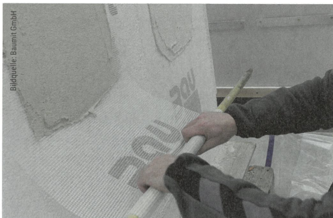
Abb. 10: Praktischer Putzabrissversuch auf der Baustelle zur Beurteilung der Haftzugfestigkeit und Tragfähigkeit der vorhandenen Putzschicht.
