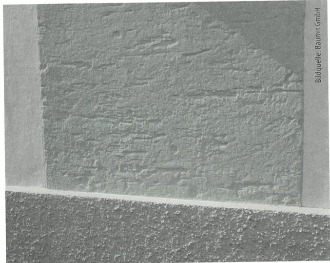
Abb. 6: Putzstrukturen im Erdgeschossbereich.
