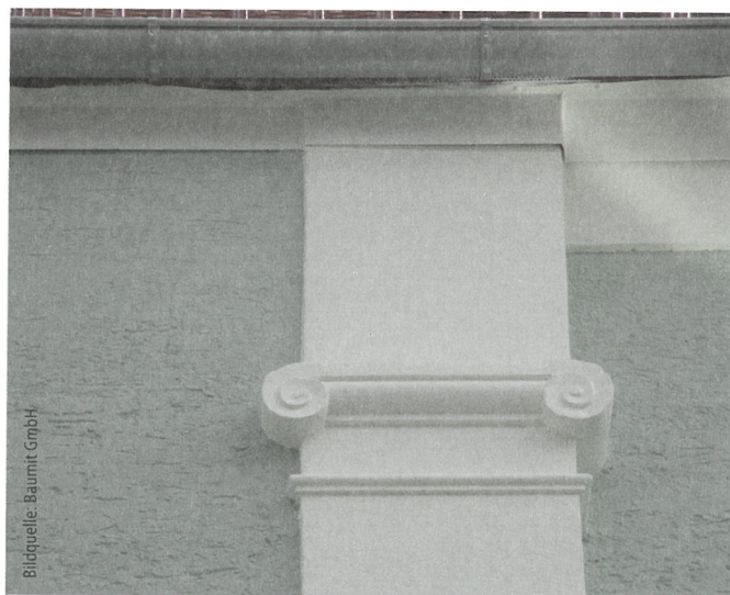
Abb. 8: Restaurierung der Volute unter der Dachtraufe.
