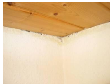
Wärmebrücke – Decke zum ungedämmten Dachgeschoss
