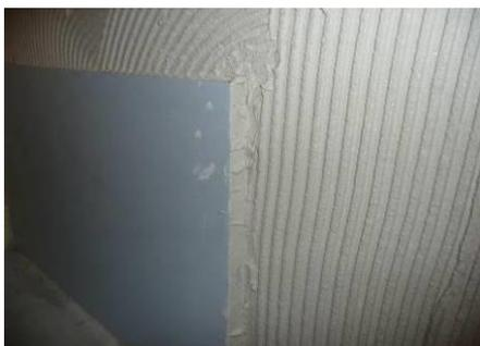
Die Stoßkante der schon aufgeklebten Platten sind satt mit AS 2 in 1 Putz zu versehen.
