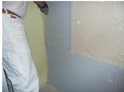
Alle Plattenkanten gut mit Mörtel verkleben (Lager- und Stoßfugenverklebung). Die Platten sind im Versatz zu montieren, dabei keine Kreuzfugen ausbilden.
