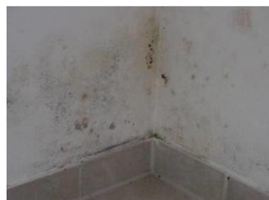
Schimmelbildung aufgrund von Kondensat
