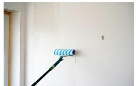
Untergrund vorbereiten, Unebenheiten und Löcher ausgleichen, MultiPrimer mit Airless-Gerät auftragen, Spachtel auftragen und nachglätten. Die getrocknete Oberfläche mit der Giraffe schleifen, anschl. mit MultiPrimer grundieren zur Anstrichvorbereitung (optional mit der Rolle).
