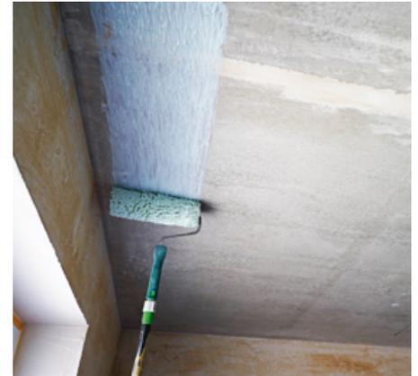
Die dickflüssige Grundierung GelPrimer wird nach kurzem Aufrühren entweder maschinell mit einem Airless-Gerät oder mittels Rolle aufgetragen. Der besondere Vorteil bei beiden Varianten: der GelPrimer ist absolut spritzfrei, gleichmäßig aufzutragen und dringt tief in den Untergrund ein. Vor allem bei Deckenflächen ist das saubere Verarbeiten von Vorteil.
