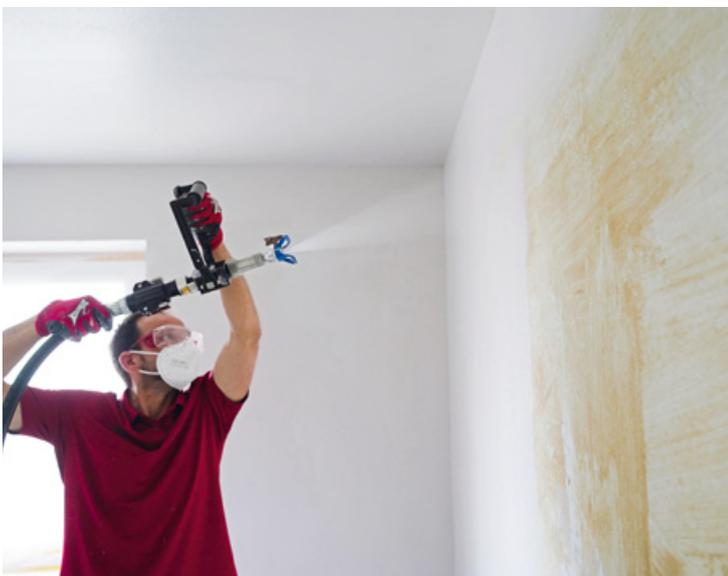
Am Beispiel Ionit-Finish ist das sehr nebelarme Auftragen mit dem Airless-Gerät hervorzuheben. Das begünstigt die leichte Verarbeitung und minimiert den Abdeck-Aufwand.
