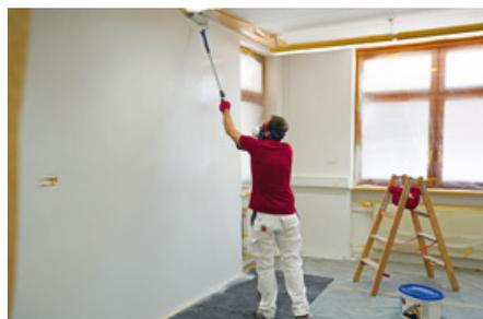
Farbe DivinaObjekt mit dem Airless-Gerät auftragen. Anschließend nachrollen, um eine gleichmäßige Verteilung der Farbe zu erreichen. Das Nachrollen hat weiterhin den Vorteil, dass zukünftige Ausbesserungen mit der Rolle erfolgen können, um die feine Struktur zu erhalten.
