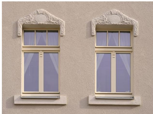
getrennt als sogenanntes Bossenwerk. In historischer Kellen-Wurf-Technik ausgeführt rundet diese besondere Oberfläche das Gesamtbild des Gebäudes ab.
