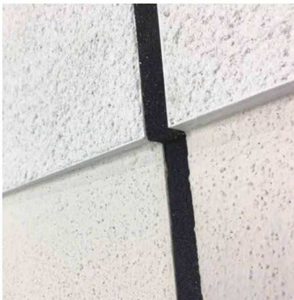
Schlagregensicherer, bewegungsfähiger Fugenverschluss dank Fugendichtband - in Schwarz oder Anthrazit.
