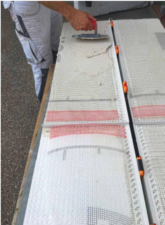
Supra Compact-Profile mit verschiedenen Stegbreiten werden mit Steckverbinder zusammengefügt und PVC-Abschlussprofil im 90° Winkel angeklebt.
