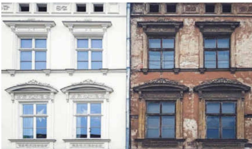
Gründerzeit-Fassade: links gut saniert, rechts mit schweren Feuchteschäden und sichtbaren Ausblühungen.
