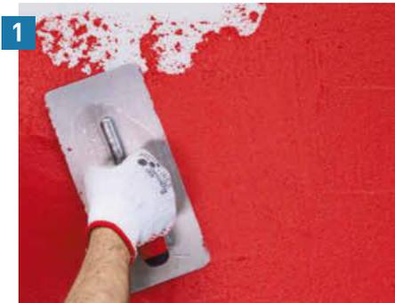
**1** Der Putz wird auf den vorbereiteten Untergrund in einer gleichmäßigen Schichtdicke etwas über Korn mit einer Glättkelle aufgezogen.
