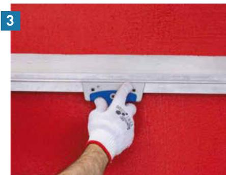
**3** Anschließend wird der durchgezahnte Putz mit einem Flächenspachtel („Schmetterling“) gleichmäßig abgeglättet.
