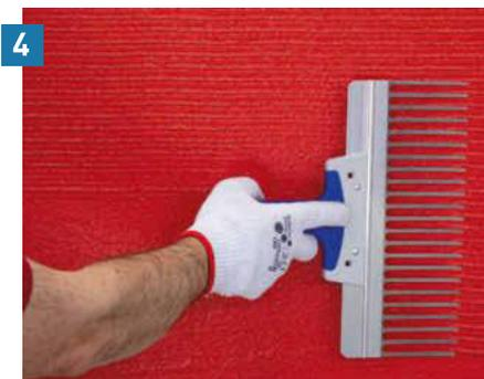
**4** Der noch feuchte Putz wird mit einem Putzkamm oder einer Zahnpachtel gleichmäßig und mit leichtem Druck strukturiert.
