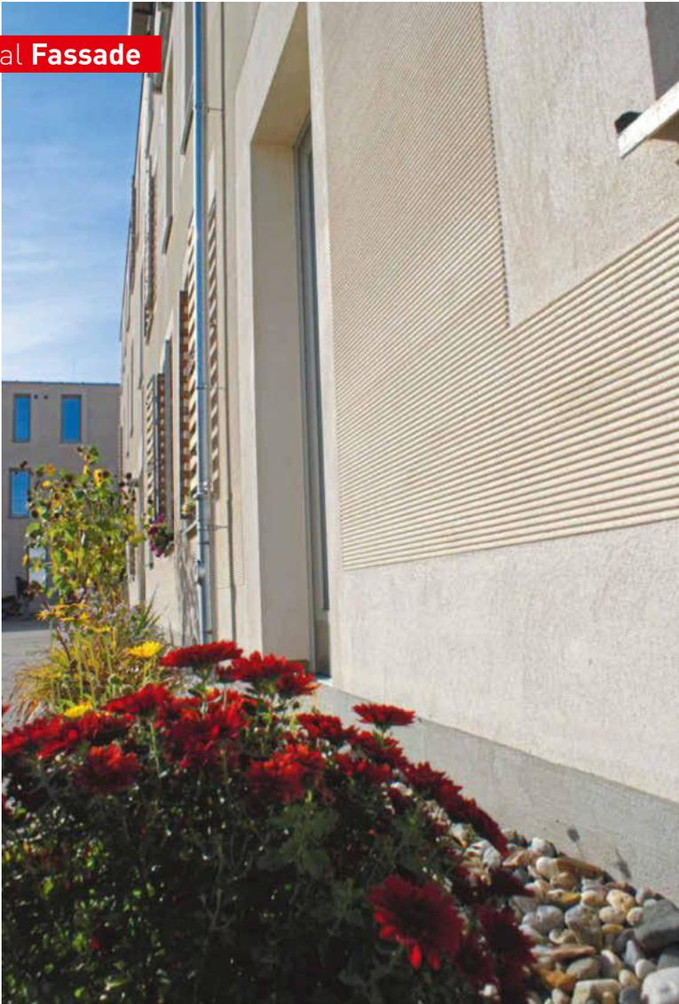
„Bramschkontor“ in Dresden: Mit dem ungestrichenen, durchgefärbten Kammputz im Wechsel mit glatten Putzflächen wurde an der Fassade ein gestalterischer Akzent gesetzt.
