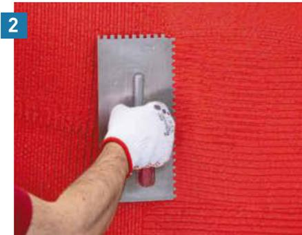
**2** Um eine gleichmäßige Schichtstärke zu erzielen, wird der Putz mit einer Zahntraufel mit entsprechender Zahnung abgezogen.
