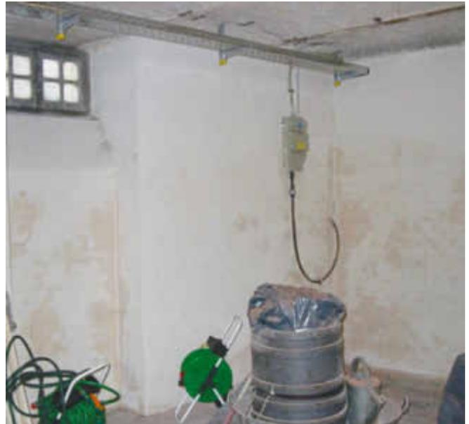
Durchgeschlagene Salze im neu aufgetragenen Sanierputz: Schichtdicken wurden nicht eingehalten; zusätzlich konnte der frische Putz aufgrund zu hoher Luftfeuchtigkeit nicht schnell genug abtrocknen.
