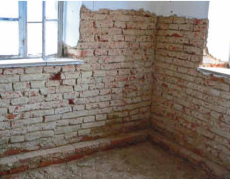
Das aktuelle WTA-Merkblatt bietet auch Bewertungsmöglichkeiten für Materialproben, wenn der Putz bereits abgeschlagen wurde.
