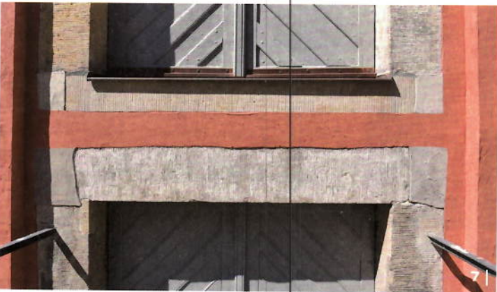
6 | Anhand der vorliegenden Mörtelproben wurde ein historischer Oberputz mit nachempfundenem Putzaufbau eingesetzt, den man im rötlichen Farbton des Befunds bzw. der denkmalpflegerischen Vorgaben einfärbte. Damit ließ sich die gewünscht lebhaftige Struktur erreichen.
