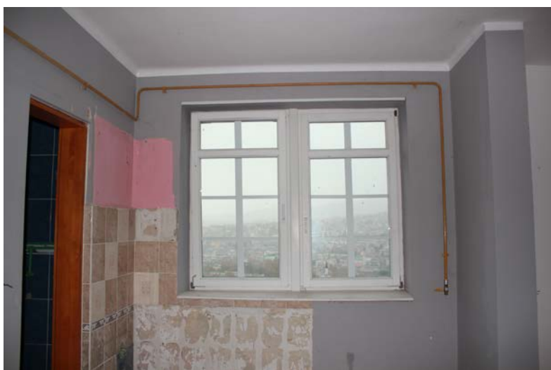
Slike 62-64. Postojeće stanje potkrovlja
