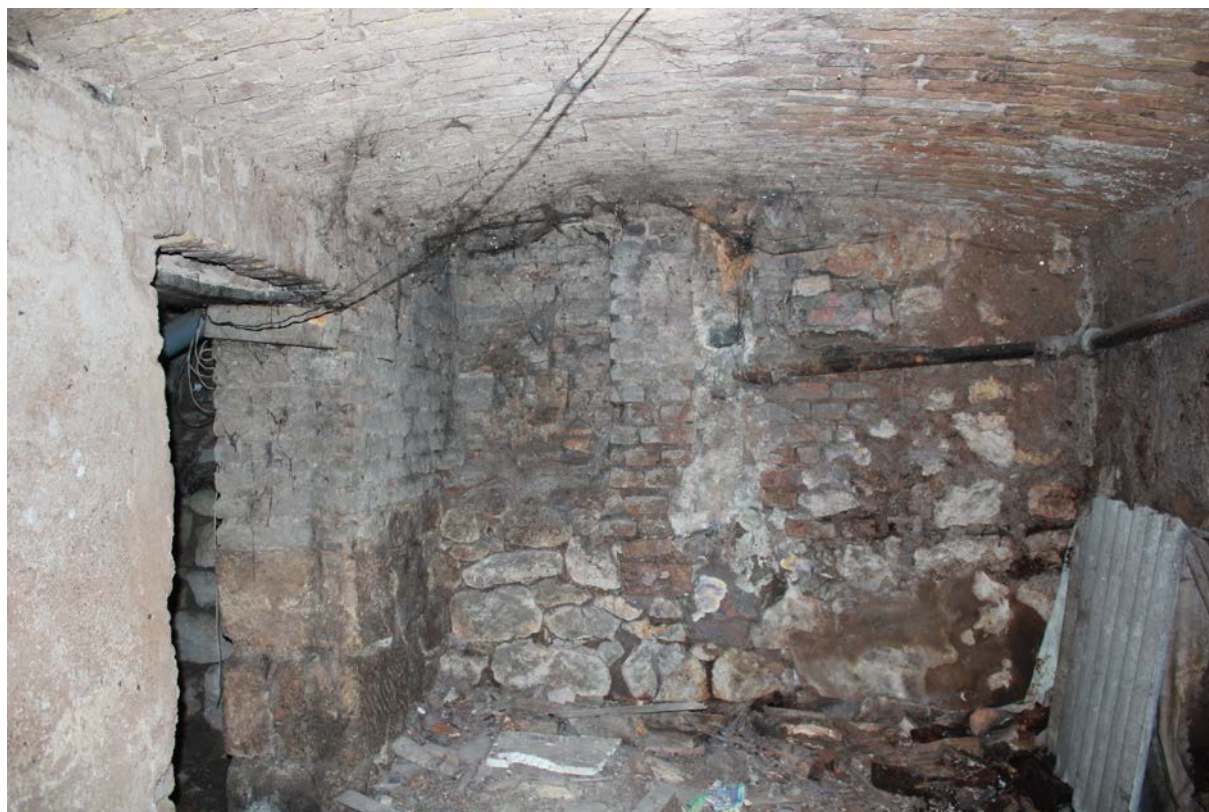
Slike 49 i 50. Postojeće stanje podruma
