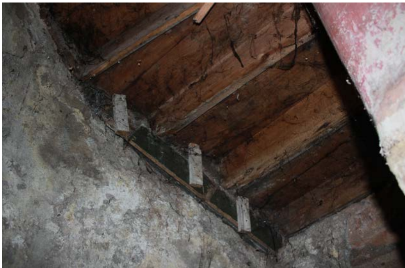
Slike 65-67 Postojeće stanje potkrovlja
